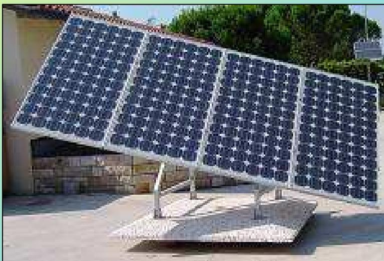
Il generatore fotovoltaico viene collegato alla rete attraverso un *inverter* che trasforma la corrente continua prodotta in corrente alternata compatibile con la rete e permette di estrarre in ogni momento la massima potenza dal generatore fotovoltaico. Un contatore interposto tra l'inverter e la rete contabilizza l'energia prodotta dal generatore e quella assorbita dalla rete.
