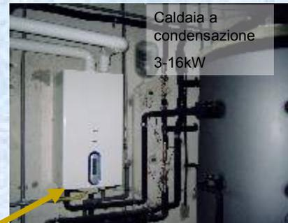
Caldaia a condensazione 3-16kW
