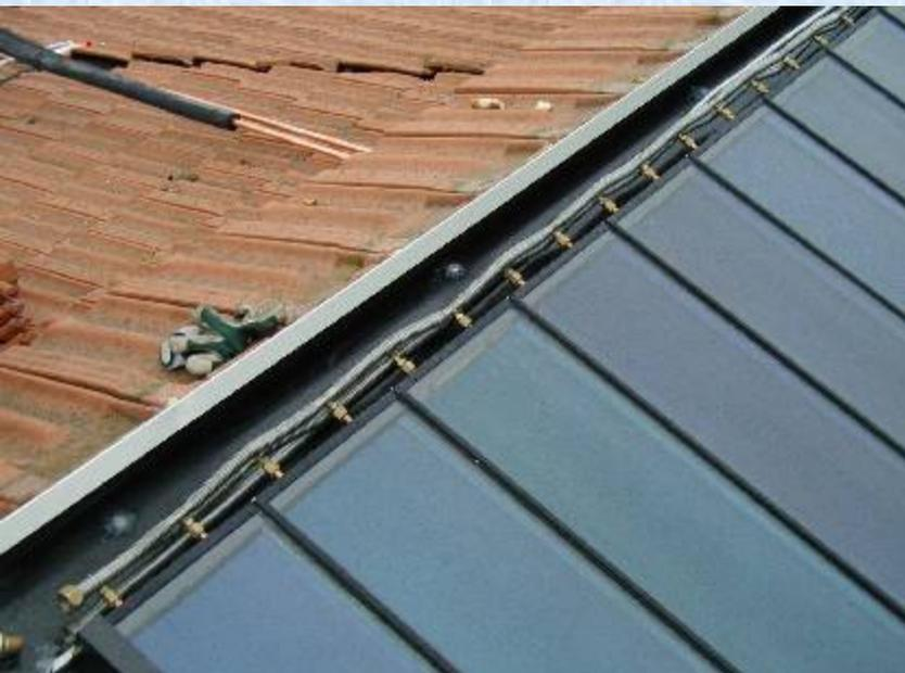
PARTICOLARE COLLEGAMENTI IDRAULICI
