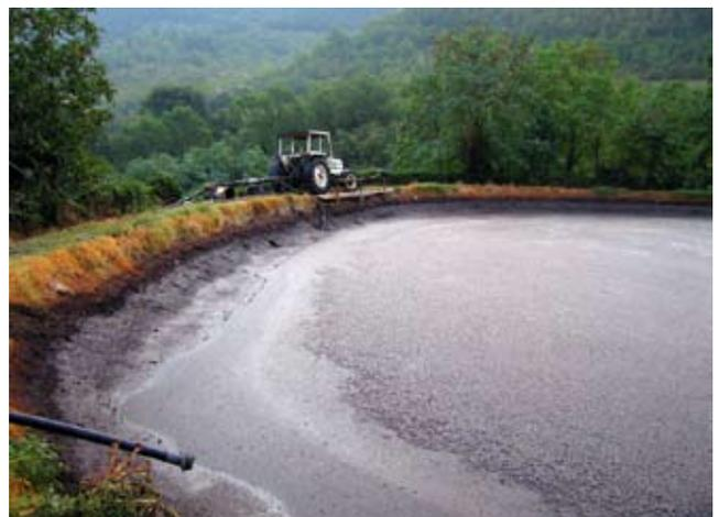
Bacino stoccaggio liquami, di diametro pari a circa 60 m, posizionato troppo vicino al fiume ed in posizione sopraelevata: in caso di perdita il liquame percola direttamente nel corso d'acqua.
